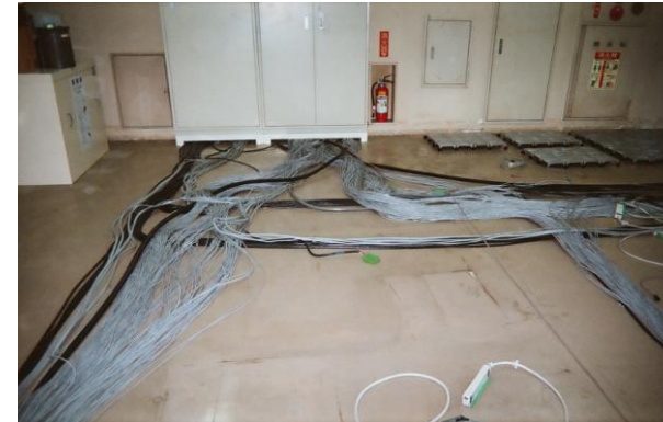
サーバー周辺から246YHパネル敷設
