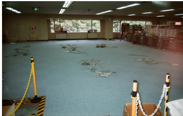
タイルカーペット敷設完了・机パソコン再配置前
