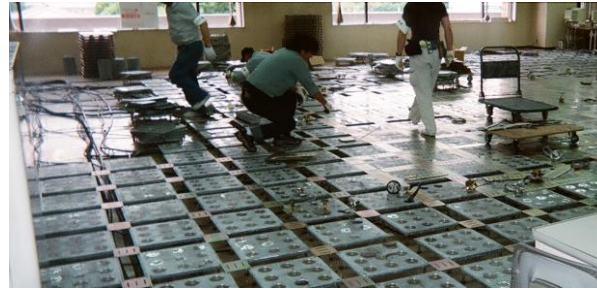
既存支柱式OAフロア撤去
