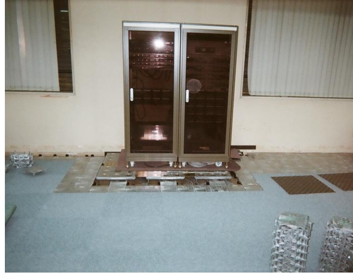
サーバー周辺パネル工事と配線収納
