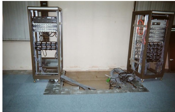
配線収納・246YH敷設パネルセット
