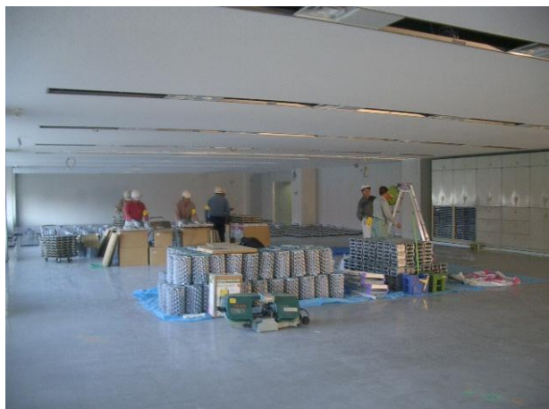
床下空間(PC配線収納) 天井高の確保・グレーチ
